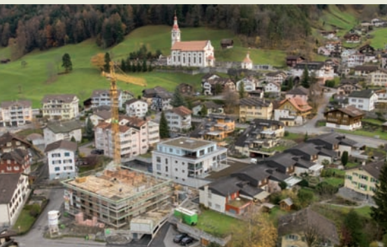
Im 11. Jahrhundert stand im Mühlehof der Wohnturm von Schattdorf. Nun entstehen hier zwei Mehrfamilienhäuser.
