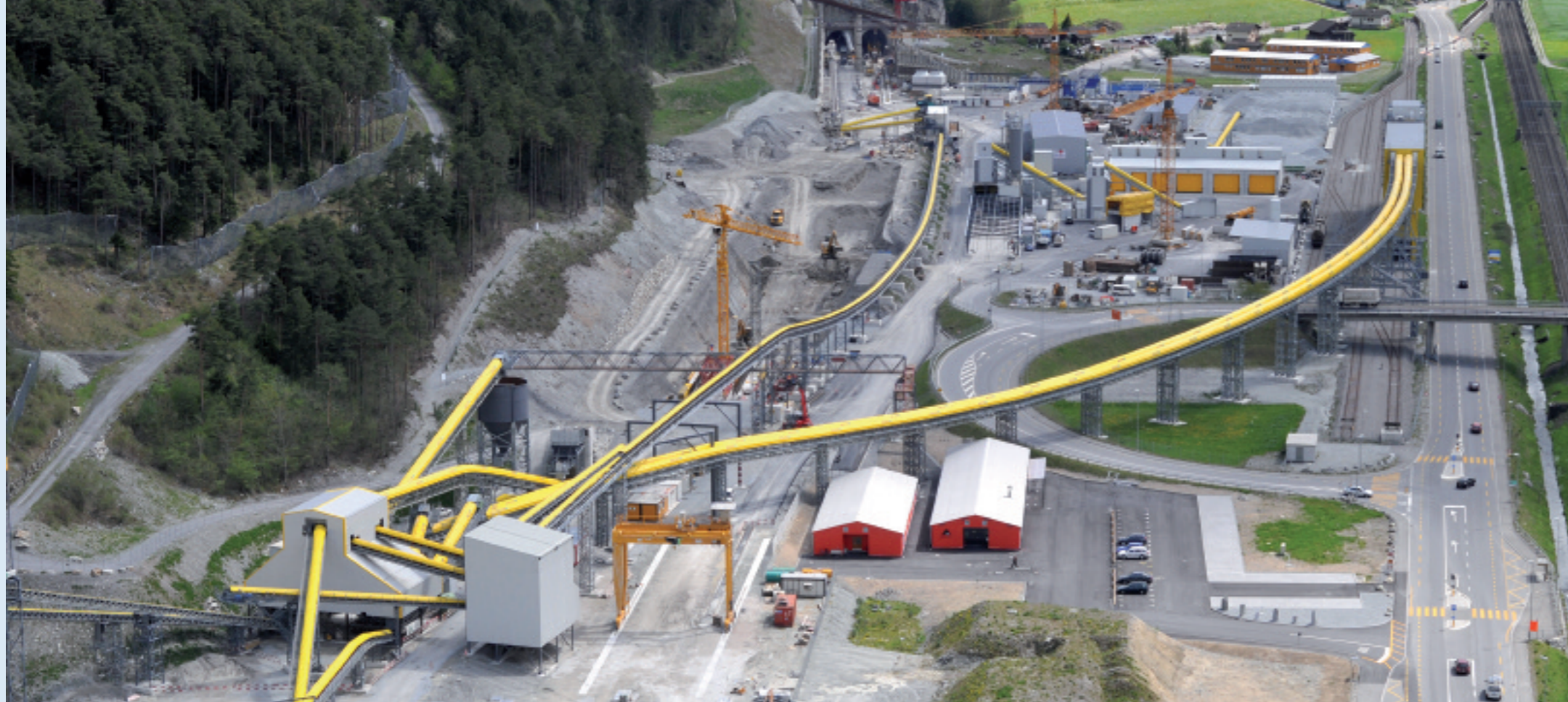
Im Neat-Los 110 bei Erstfeld liegt der Betriebsauftrag für Umschlagtechnik bei der Aggregat AG. Davon zeugen imposante 20 Kilometer lange Förderbänder.
