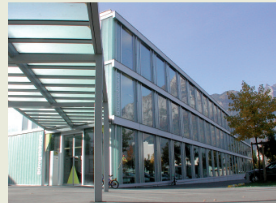
Das Glasfasernetz wird vom EWA-Hauptsitz in Altdorf überwacht und koordiniert. Spezialisten stellen sicher, dass private Leitungen auch wirklich privat bleiben.
