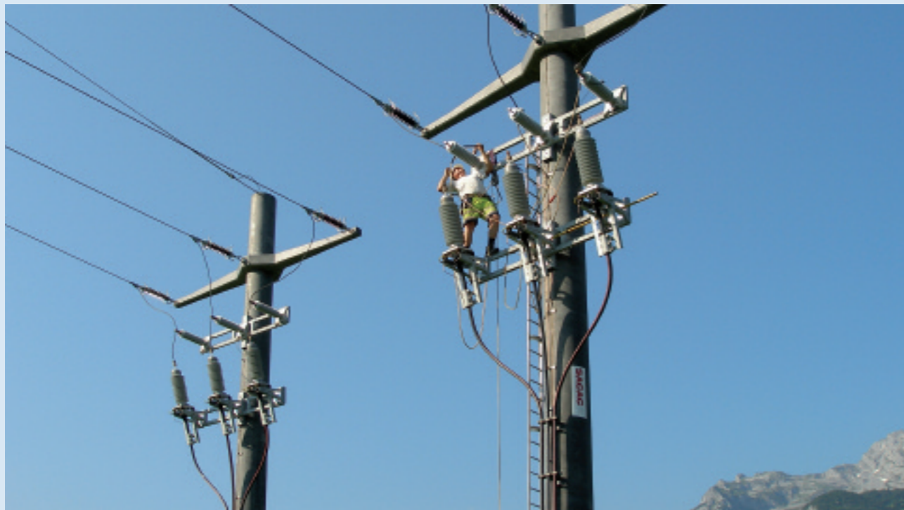
Arbeiten in luftiger Höhe: Ein Teil der Freileitungen in Schattdorf musste wegen der NEAT ersetzt werden.
