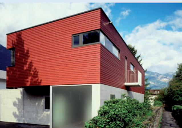
Holz liegt im Minergiebau ganz im Trend.
