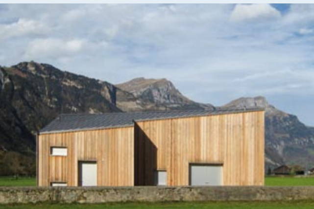
Klein und fein: das Trinkwasserpumpwerk Altdorf.
