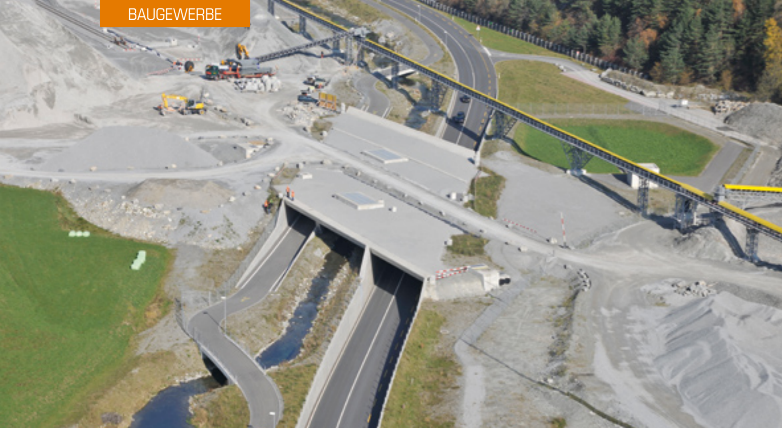
Tiefbaukunst aus der Zentralschweiz: die Neat-Unterführung im Erstfelder Rynächt.
