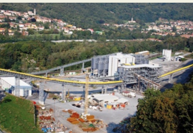
Die ARGE Comestei bewirtschaftet am Ceneri rund 6,5 Millionen Tonnen Ausbruchmaterial.
