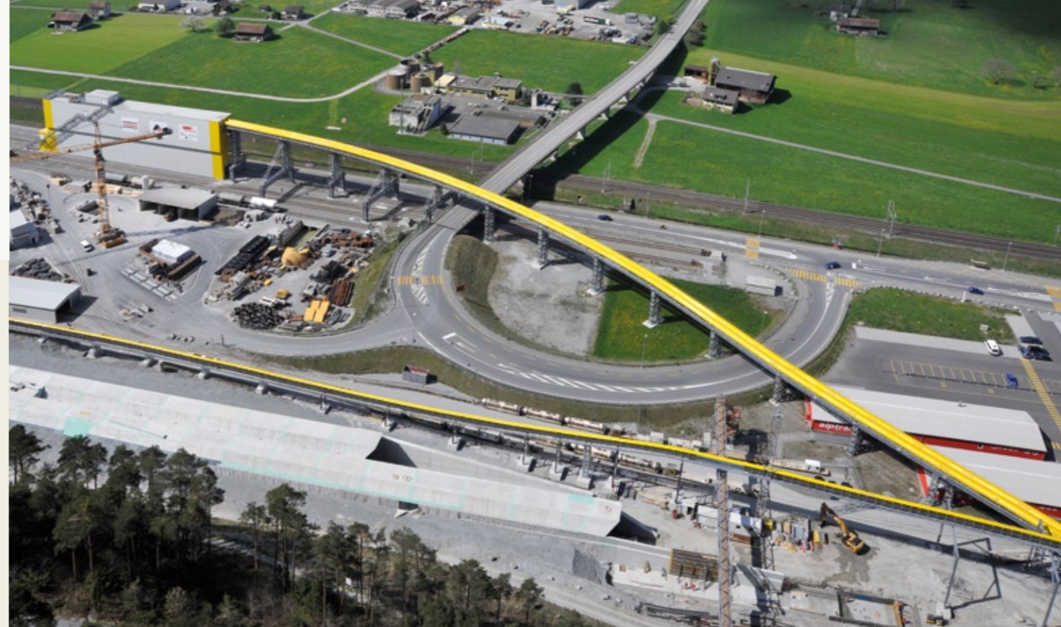
Die Bandanlagen der ARGE Uristei in Erstfeld/Amsteg erbringen Stundenleistungen von 1000 Kubikmeter – rund um die Uhr.
