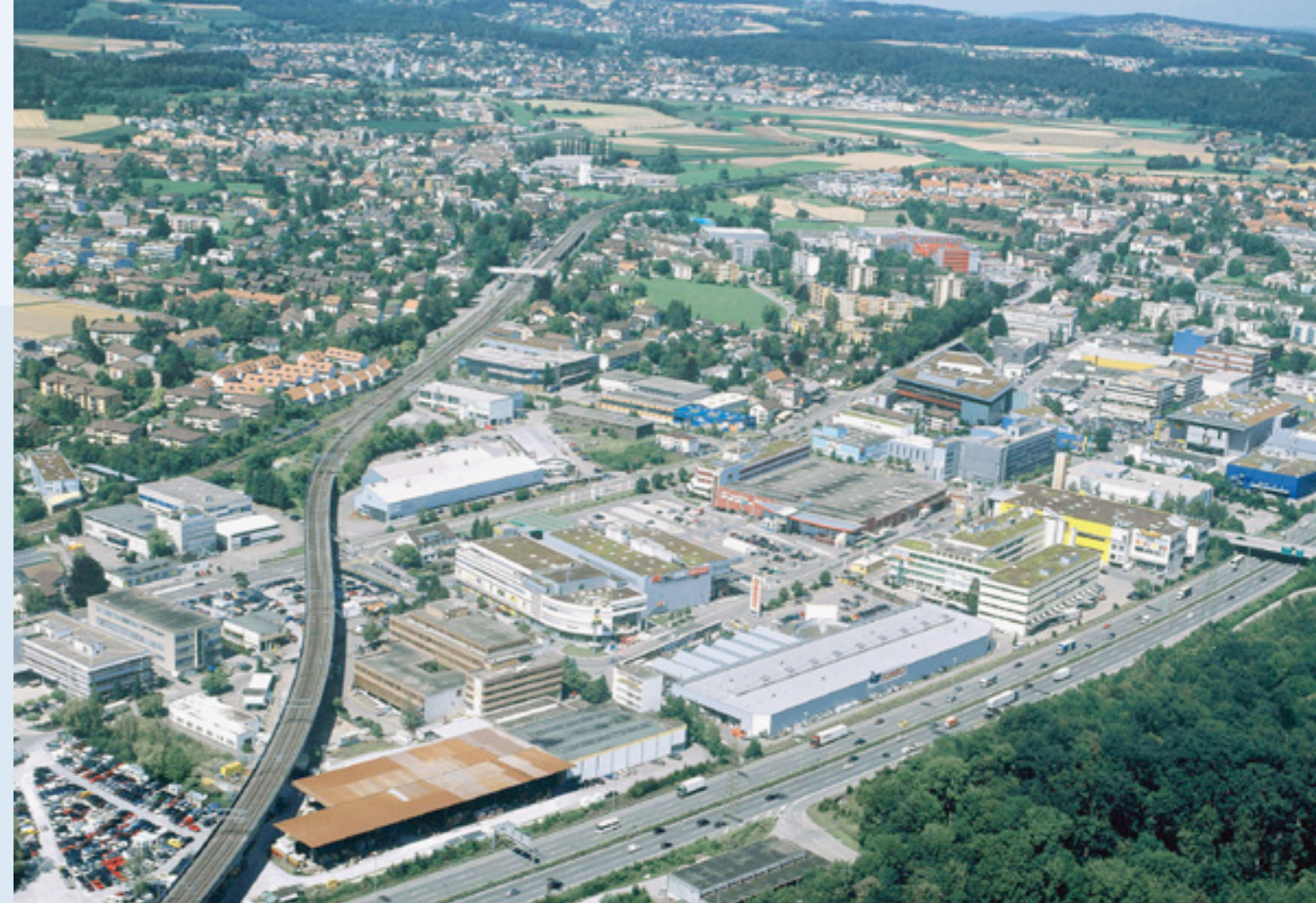
Die Betriebe im Industriegebiet Dietlikon Süd haben neu direkten Zugang zum Glasfasernetz – dank Know-how von Dätwyler Cables.
