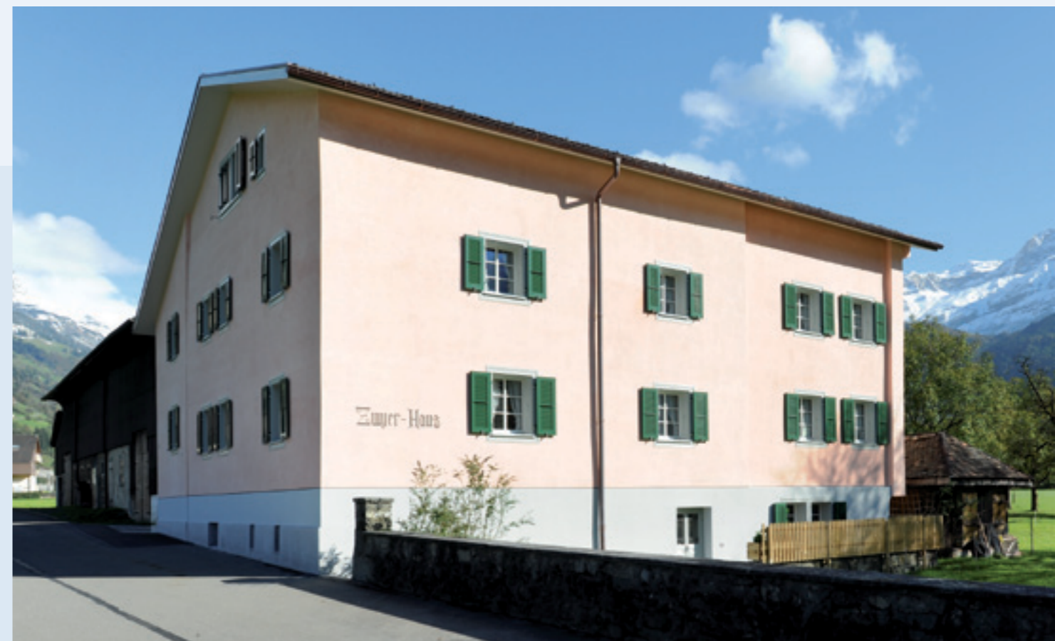
Das älteste Altdorfer Wohnhaus an der Zwyrergasse ist seit der Sanierung ein schöner Blickfang.
