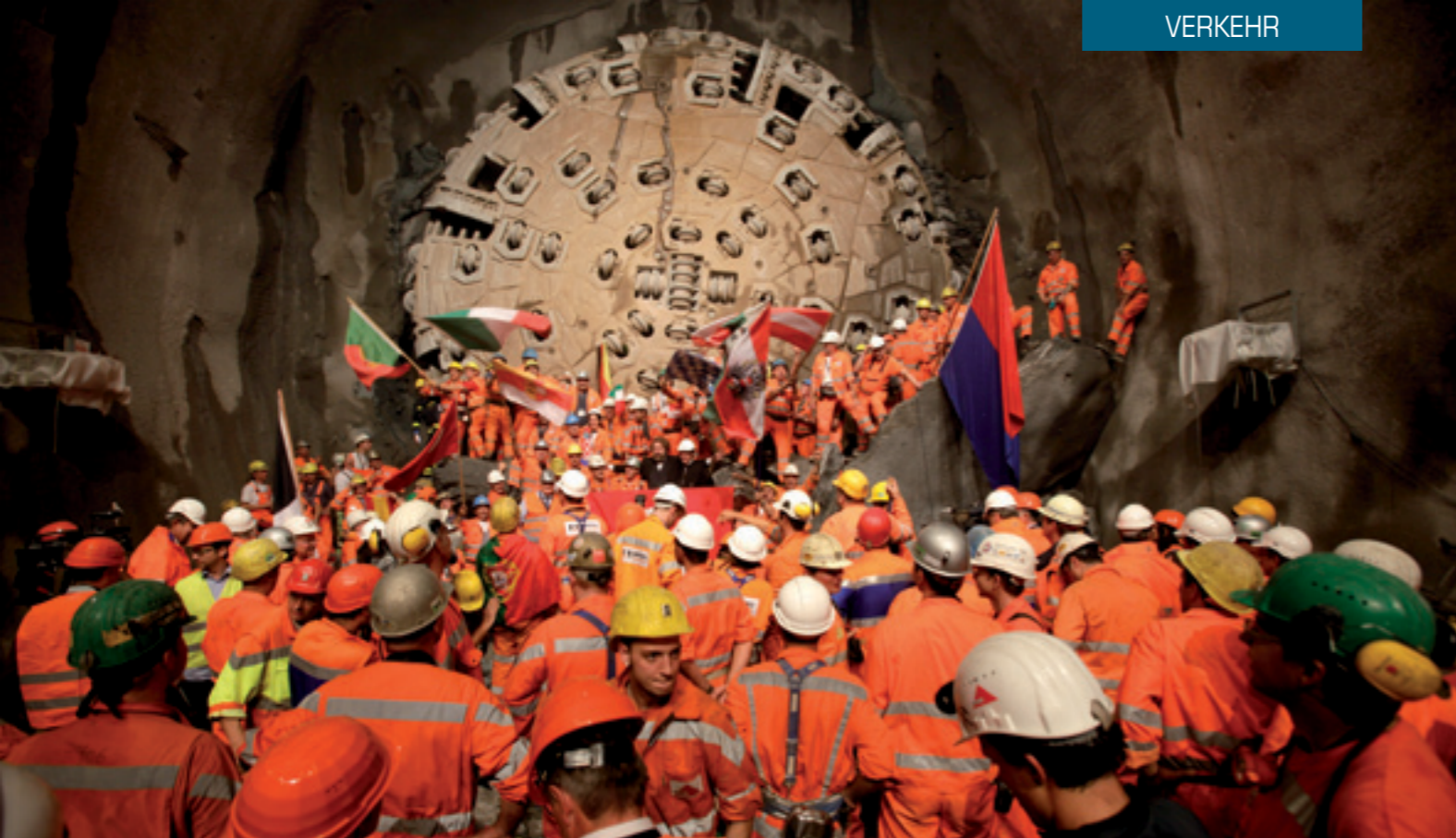
Ein Meilenstein in der Geschichte der Eisenbahn und des Tunnelbaus: Hauptdurchschlag im Gotthard-Basistunnel am 15. Oktober 2010.
