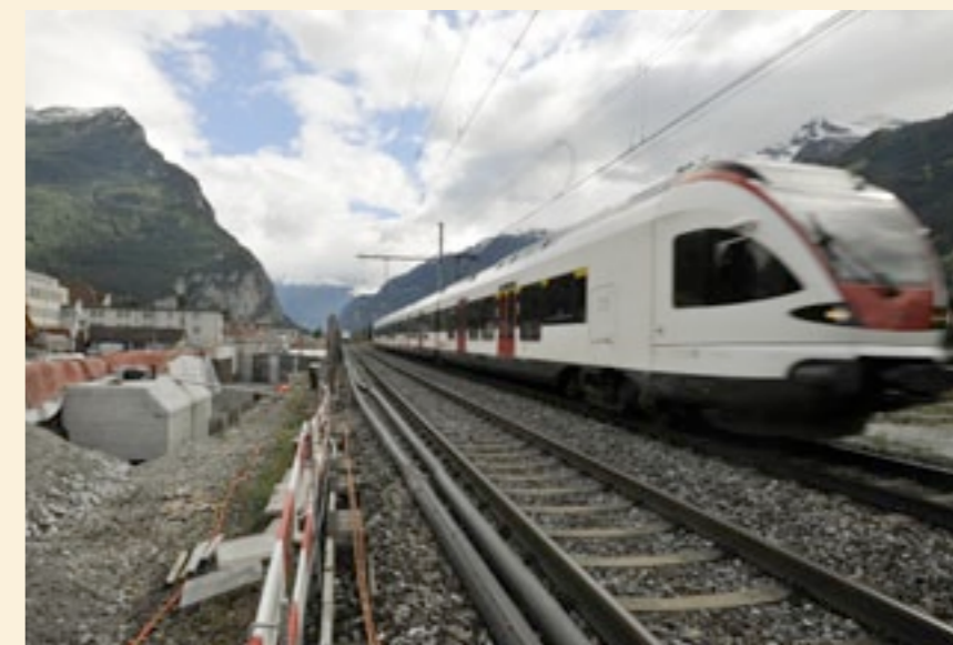
Der Bahndamm im Rynächt wird das Schattdorfer Industriegebiet vor Hochwasser schützen.
