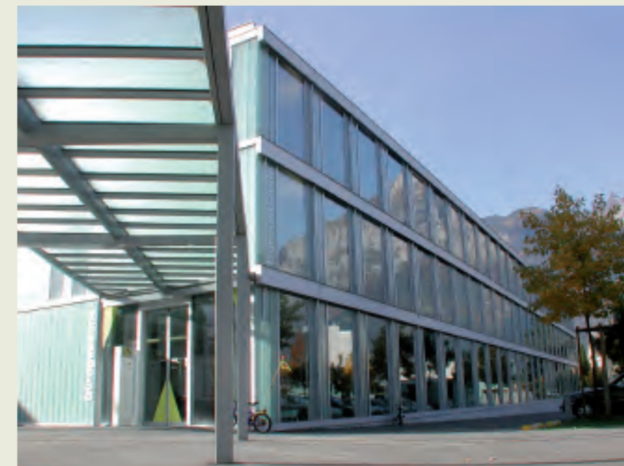
Das Glasfasernetz wird vom EWA-Hauptsitz in Altdorf überwacht und koordiniert. Spezialisten stellen sicher, dass private Leitungen auch wirklich privat bleiben.
