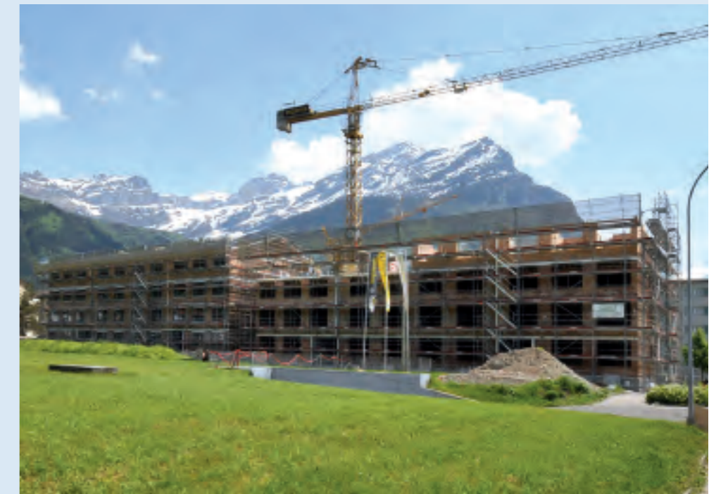
Die Neubauten fügen sich bestens ins Quartier ein.
