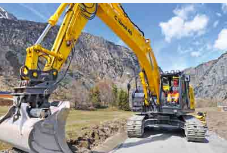
Entwässerungsarbeiten in Andermatt.
