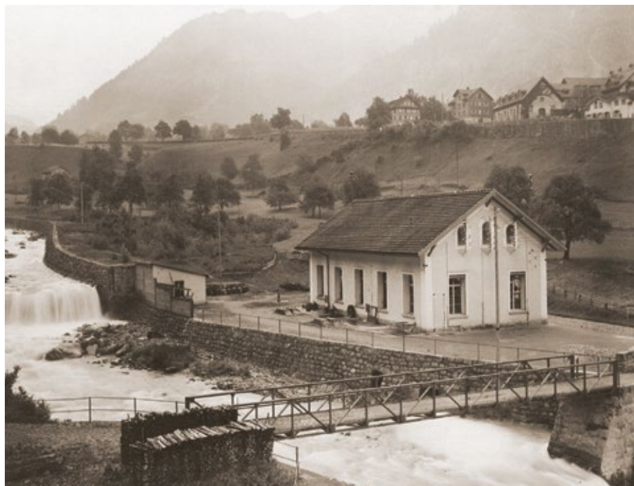
Hier begann die EWA-Geschichte: Das Kraftwerk Bürglen (Aufnahme von 1910).
