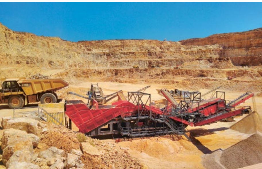
Die grösste GIPO-Brechanlage mit einem Gewicht von 220 t im Einsatz in Israel.
