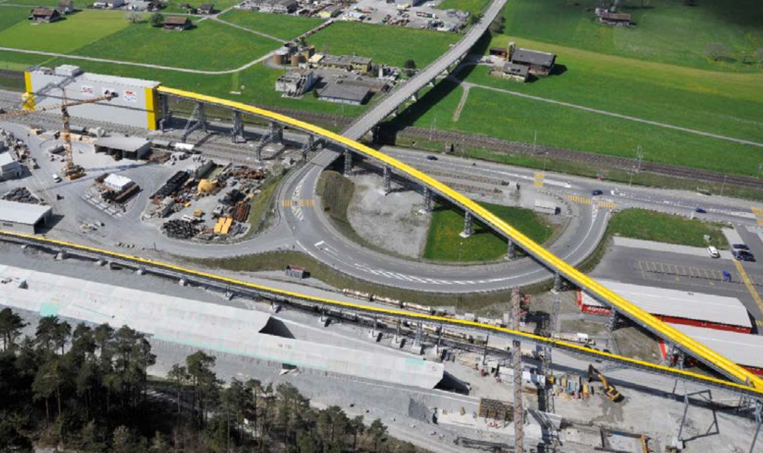
Die Bandanlagen der ARGE Urstei in Erstfeld/Amsteg erbringen Stundenleistungen von 1000 Kubikmeter – rund um die Uhr.
