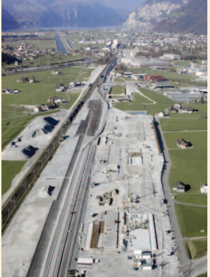
Dämme, Strassen, Schienen: Die Zukunft im Urner Talboden ist zurzeit eine grosse Baustelle.
