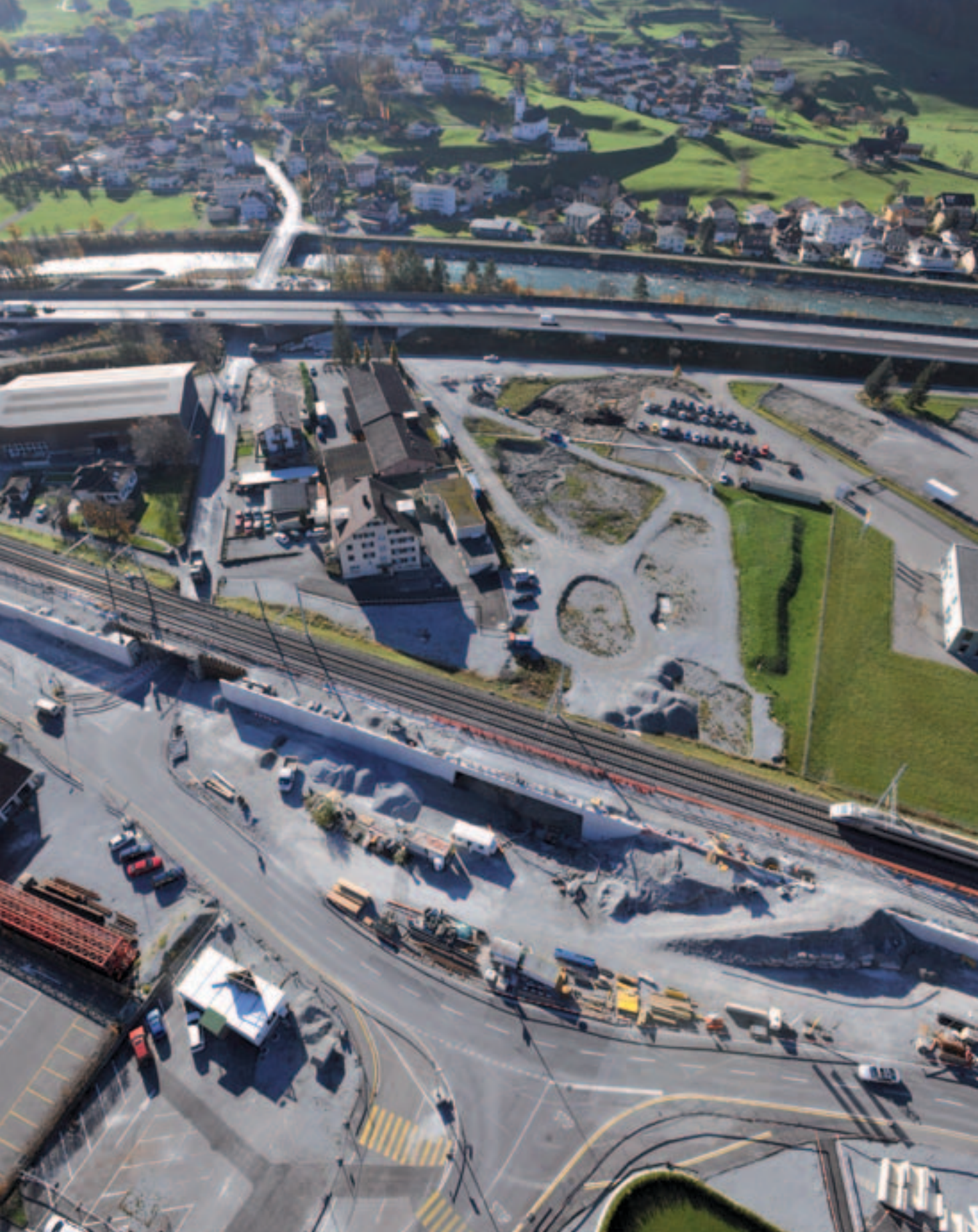
Im Zuge der Bauarbeiten wird auch das Dorf Attinghausen besser erschlossen.
