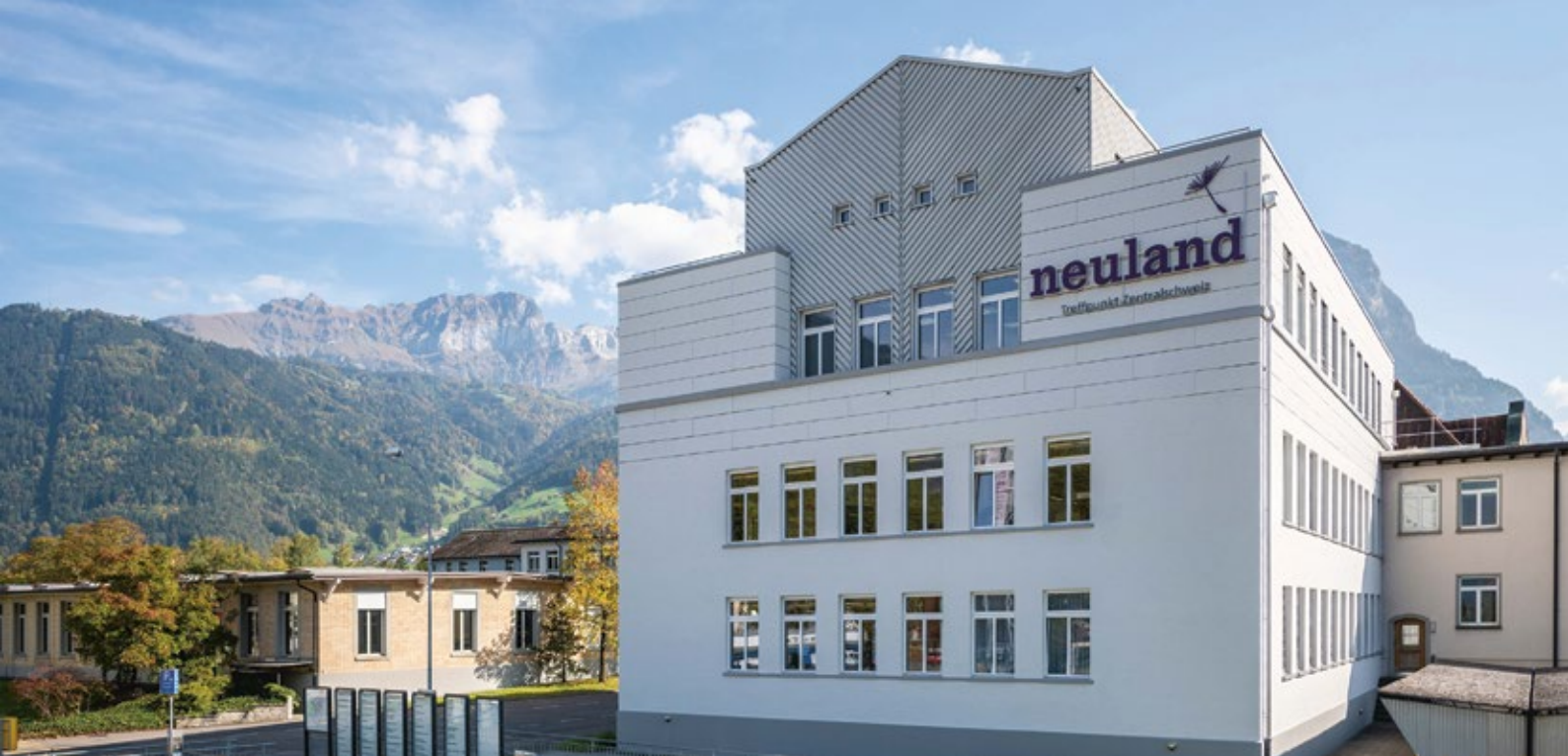
Der neue Standort der Synaxis AG Uri und der Synaxis Holding AG im «Neuland».
