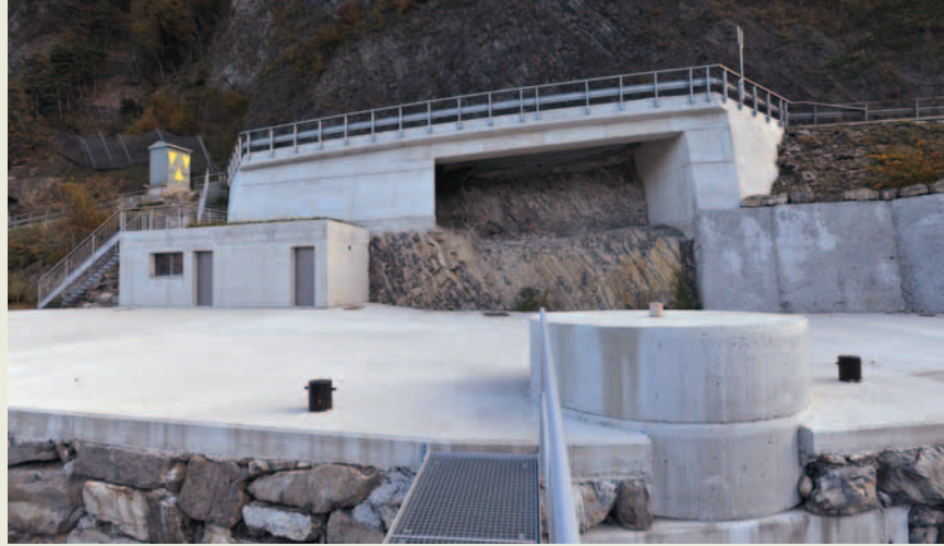
Lange Kavernen werden künftig vom Eingangsportal aus bis tief in den Fels führen.
