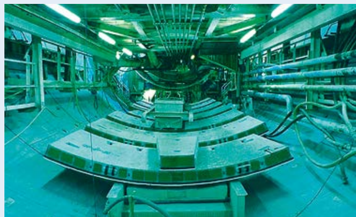
Die Tunnelbohrmaschine setzt mit Dichtungen ausgestattete Tübbinge ein.
