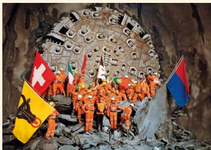
Finaler Durchbruch der Herrenknecht-TBM im Gotthard-Basistunnel.
