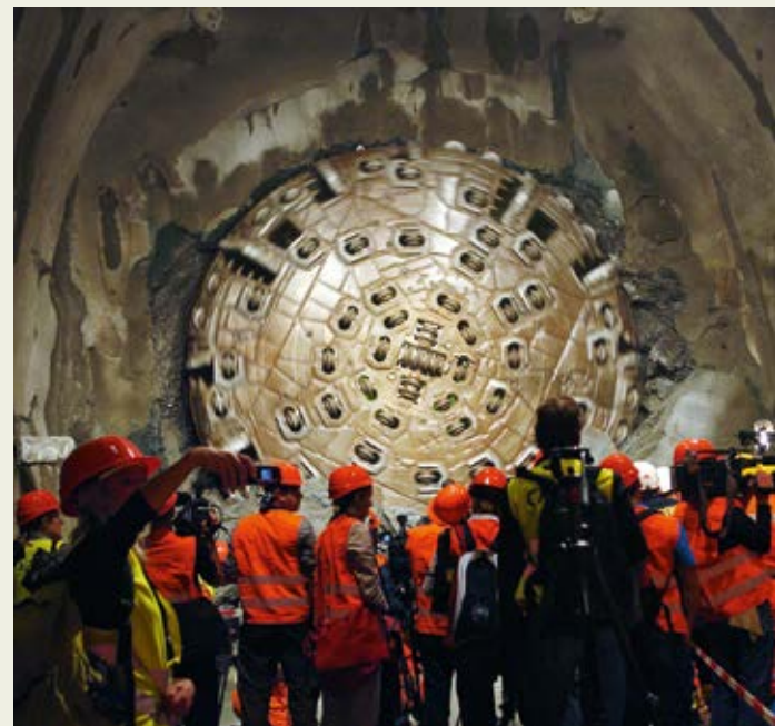
Durchstich am Gotthard-Basistunnel im Oktober 2010.
