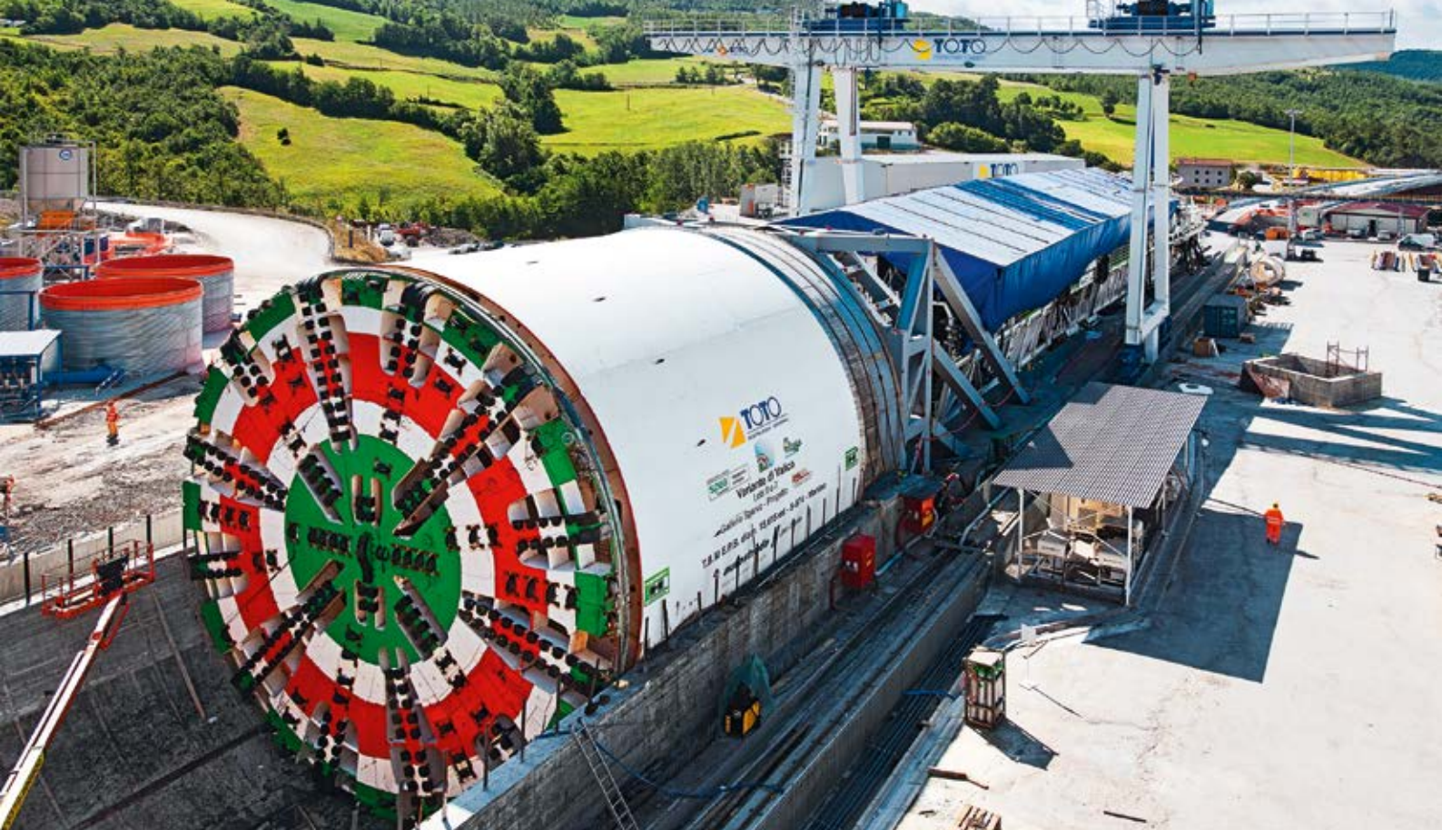
Gigantische Herrenknecht-TBM: Der bis dato weltgrösste Erddruckschild (15,5 m Durchmesser) beim Bau des Strassentunnels Sparvo in Italien.
