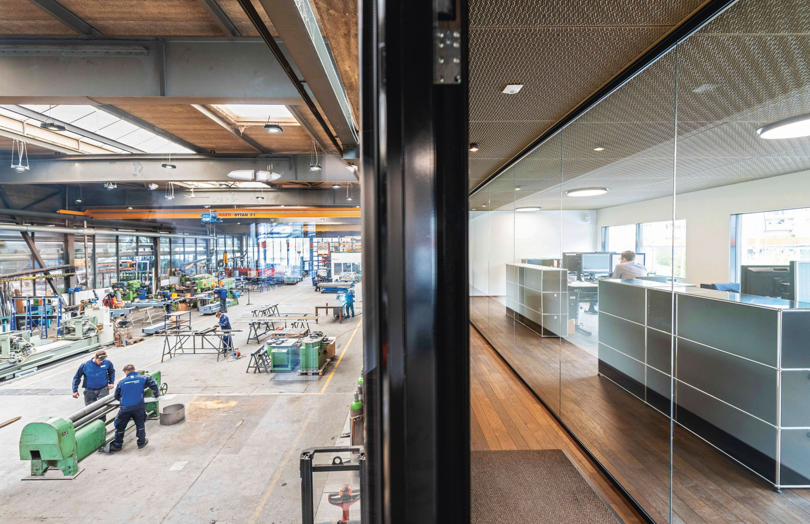
An der Rüttistrasse 13 kommen frisch renovierte Büroräume und energieeffizienter Metallbau zusammen.
