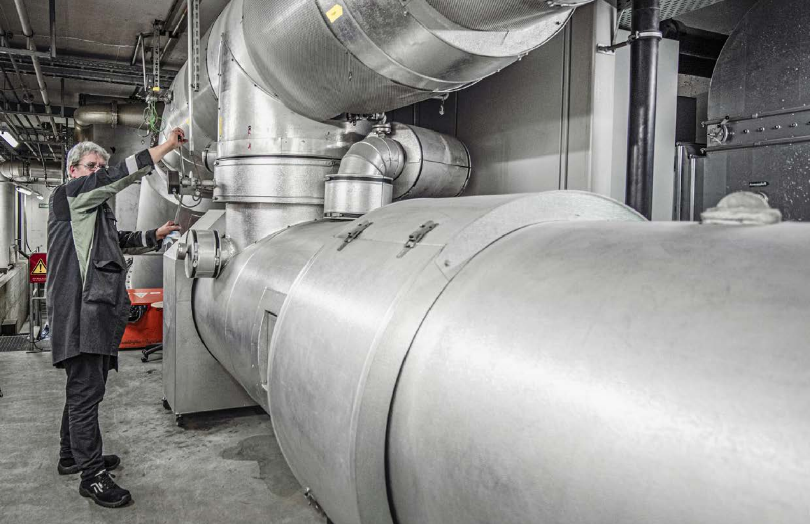
Olaf Gödeke am Wärmetauscher der Abgasreinigung.
