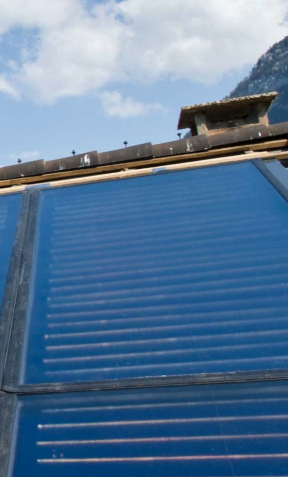
Montage einer Kollektoranlage: Nutzung der Sonnenenergie schafft neue Arbeitsplätze.
