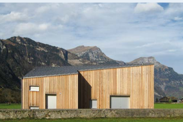
Klein und fein: das Trinkwasserpumpwerk Altdorf.
