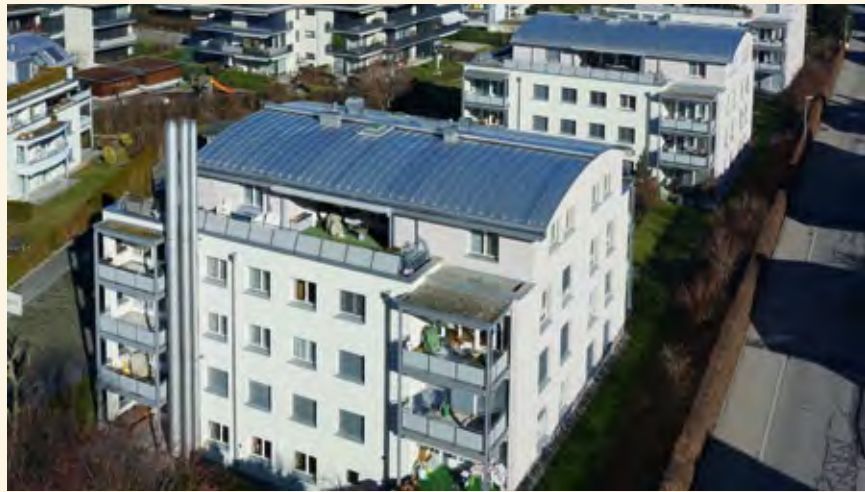
Auch ausserhalb des Kantons ist die Spenglerei Tresch tätig, wie hier mit den Doppel-falzdächern aus mattedem Edelstahl in Wollerau.
