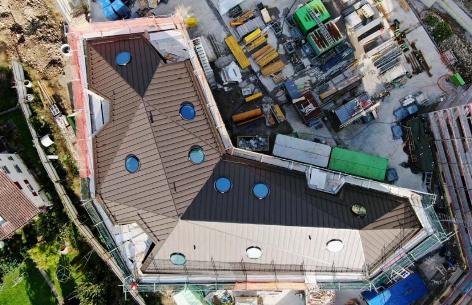
Komplexe Metalldächer wie hier bei der Überbauung Liebwylen in Schwyz sind eine Spezialität der Bless AG.
