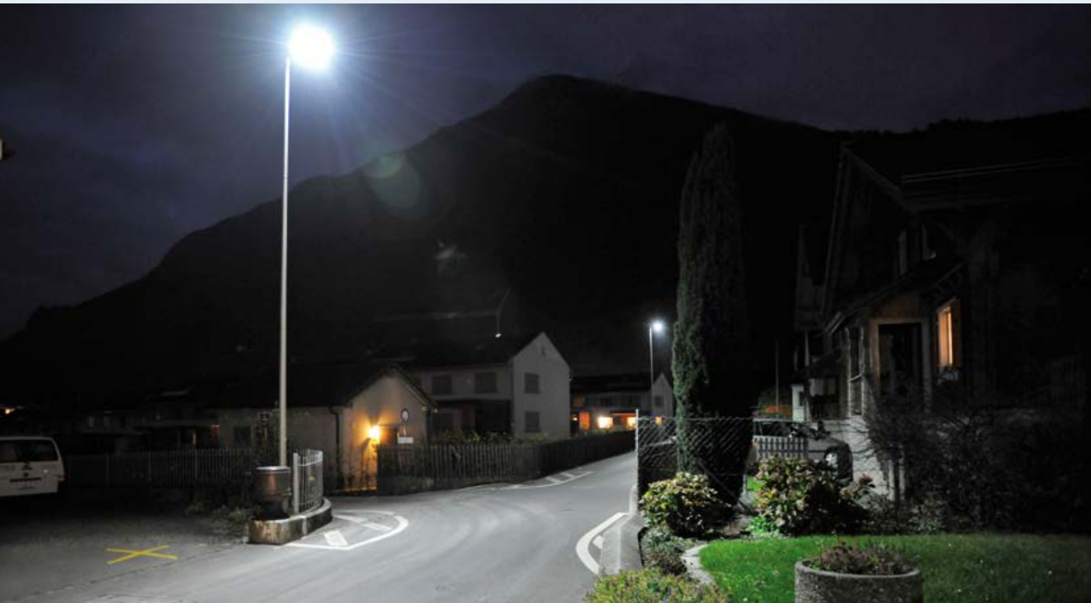
In Altdorf erstrahlen neue Strassenlampen: energiesparend, farbecht und ohne störendes Streulicht.
