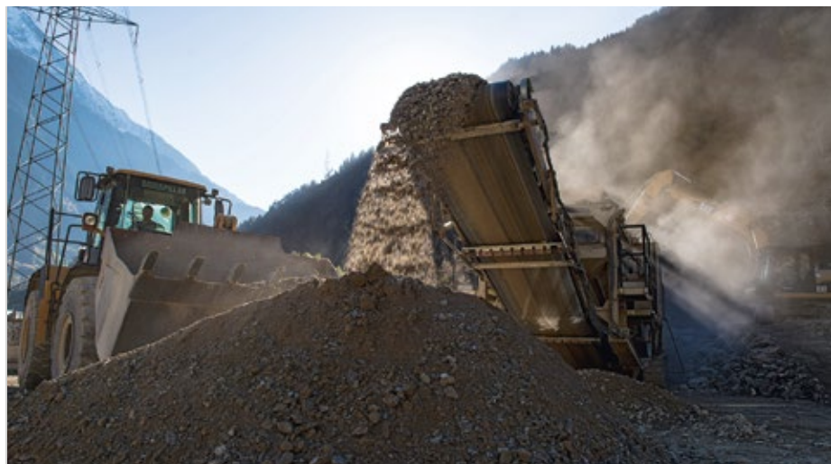
Die Inertstoff-Deponie im Gebiet Butzen bei Amsteg.
