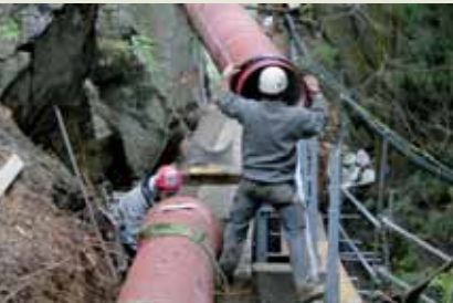
Exaktes Arbeiten zählt: bei der Verlegung der neuen Druckleitung.
