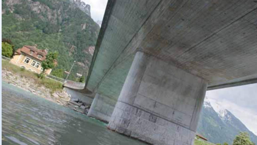
Wer in Erstfeld die Reuss überqueren will, fährt über die Schlossbergbrücke. Nur eine der zahlreichen Brückenbauten der Synaxis AG im Kanton Uri.
