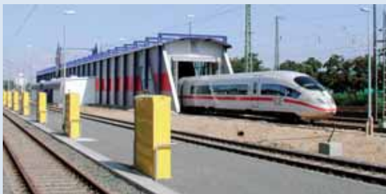
Der Maschinenbau für die Waschanlagen erfolgt von A bis Z bei der Louis Zurfluh AG.
